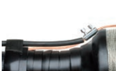
Izvođenje uzemljenja spoja električne zaštite kabela
